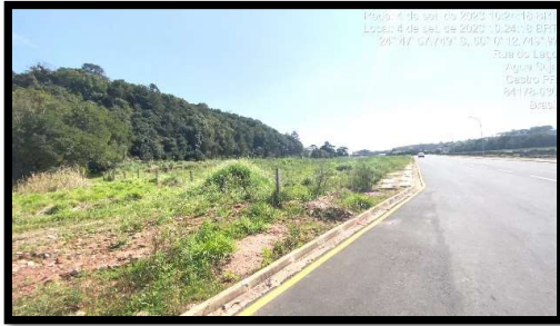
Imagem 10: Vista Sul do imóvel avaliando, Nota-se a via pública edificada. Fonte: O Perito.
