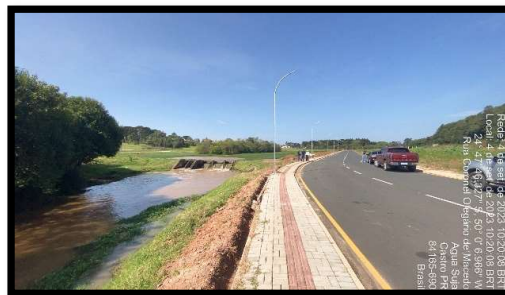
Imagem 6: Vista do imóvel frente norte. Fonte: O Perito.
