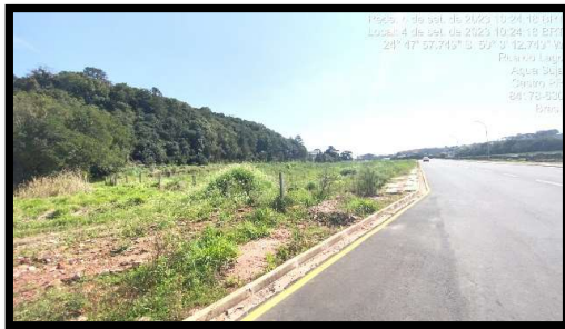
Imagem 7: Vista do imóvel frente sul. Fonte: O Perito.
